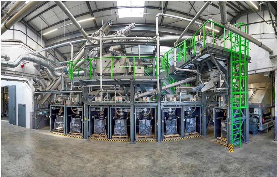
Foto 1_Redux Lithium Batterien Recyclinganlage in Bremerhaven (Fotorechte: Saubermacher)
